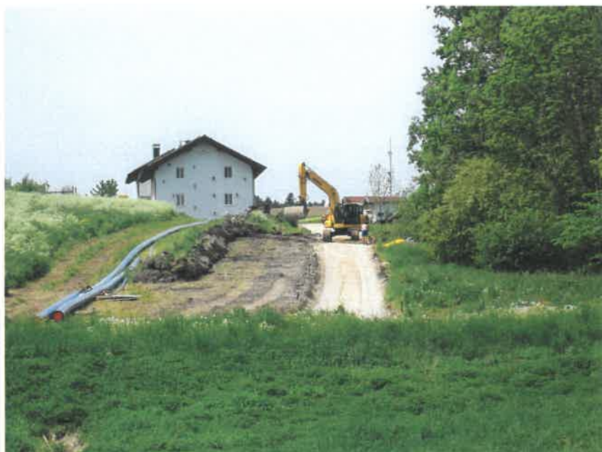
Bau der Erschließungsstraße nach Thalwies
