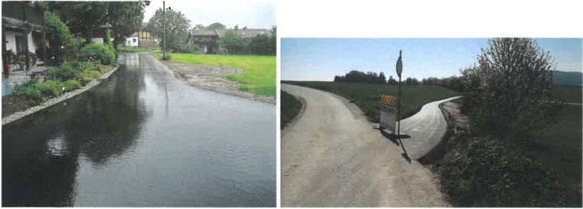
Straßenleuchtausbau 2016 in Limberg und Hochfeld/Seestr.
